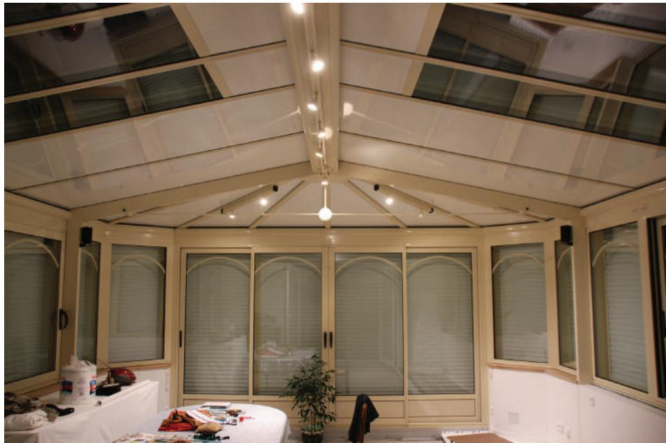
**Suivant la hauteur de la véranda**, il faudra choisir le **faisceau 40°** (pour les vérandas hautes, jusqu'à 3.5m) et plutôt le **faisceau 60°** pour toutes les vérandas avec des hauteurs de 2.5m et moins.
